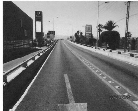
Parapeto de acero
