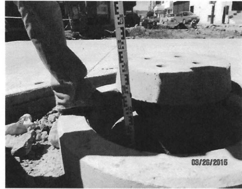
Pozo de Visita
