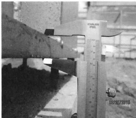
Estructura de refuerzo A-36
