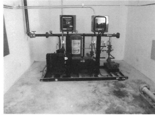
Equipo de bombeo con tableros de control
