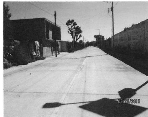
Pavimento con concreto hidráulico
