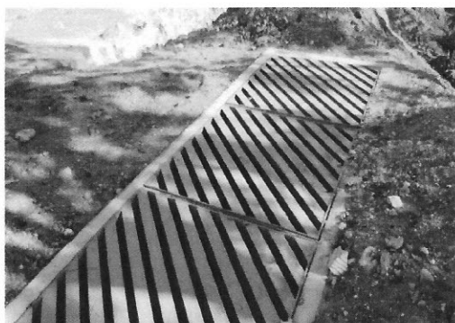
Rejillas de drenaje pluvial
