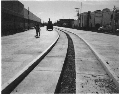
Pavimento de concreto hidráulico y ciclo vía
