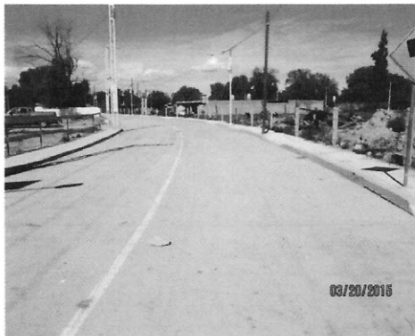
Pavimento de concreto hidráulico
