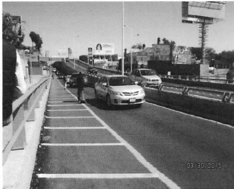
Carpeta asfáltica en rampas
