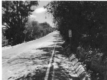
Suministro y colocación de carpeta asfáltica
