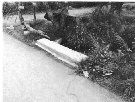
Construcción de obra de drenaje
