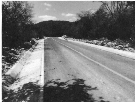
Cunetas, marcas en el pavimento y señalética
