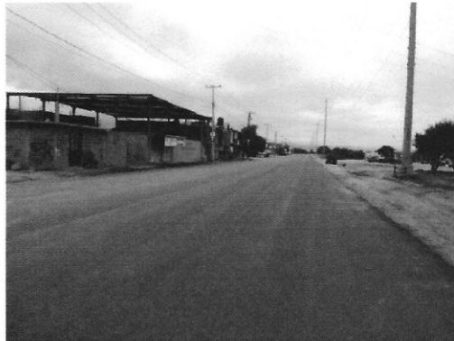
Pavimento de concreto asfáltico
