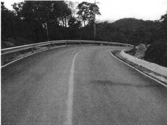
Pavimento de concreto asfáltico
