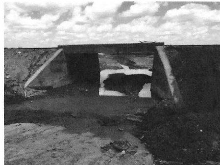
Construcción de obra de drenaje
