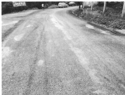
Bacheo superficial aislado, capas de rodadura y pintura
