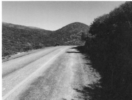
Capa de rodadura de un riego
