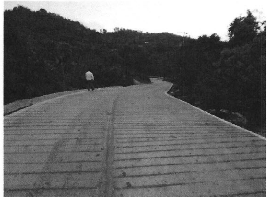
Pavimento con concreto hidráulico
