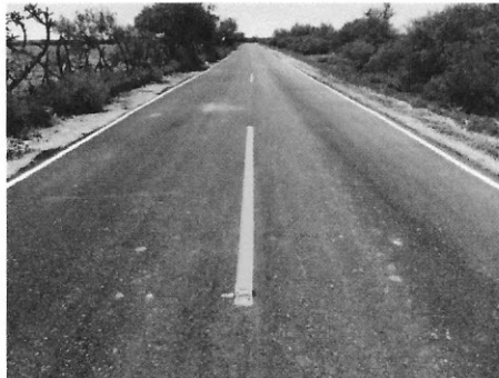
Suministro y colocación de carpeta asfáltica
