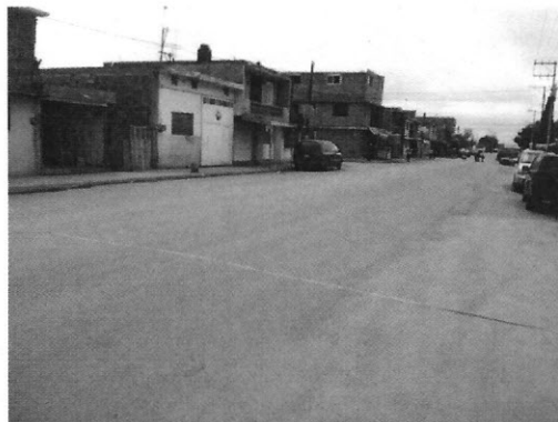
Pavimento de concreto asfáltico en bocacalles
