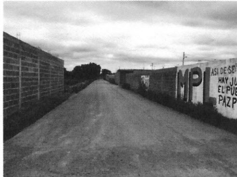
Suministro y colocación de carpeta asfáltica
