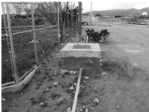
Tubería de fierro galvanizado 2" y caja de válvulas
