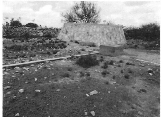
Tubería de fierro galvanizado 2" y 3", incluye coples y caja de válvulas
