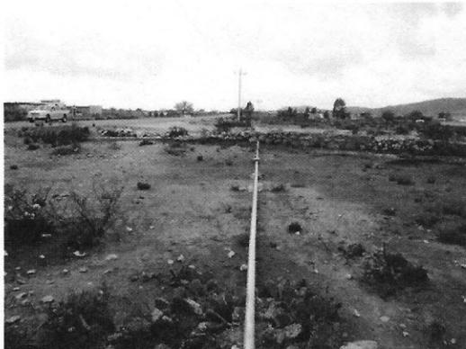
Tubería de fierro galvanizado y coples 2"
