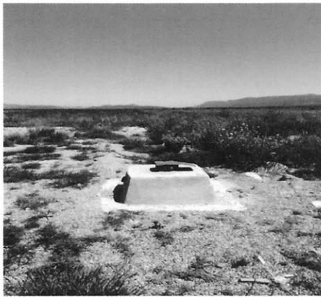
Brocal de cemento y tubería de ademe lisa de 10" de diámetro
