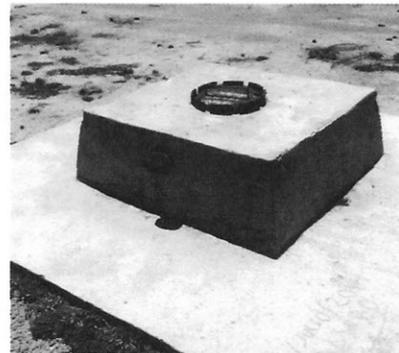
Brocal de cemento, tubería de ademe lisa de 10" de diámetro y tubos engravadores
