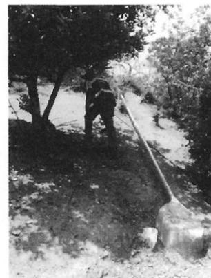
Sección de tubería y piezas especiales de fierro galvanizado
